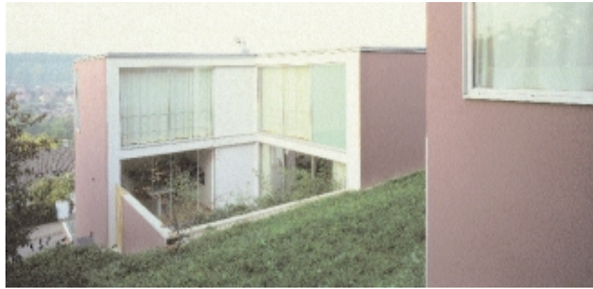
Der Innenhof, der in den steilen Hang eingegraben wurde, belichtet im unteren Haus den Wohnbereich der dritten Ebene.
